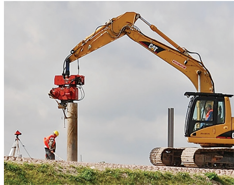
Рис. 4. Промышленный вибропогружатель свай
